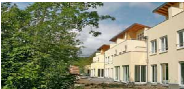
Hainberghäuser auf den Zieterterrassen kurz vor Fertigstellung 2005
