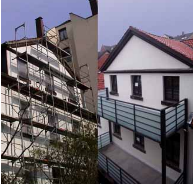
Altbauanierung in Hannover-Linden
